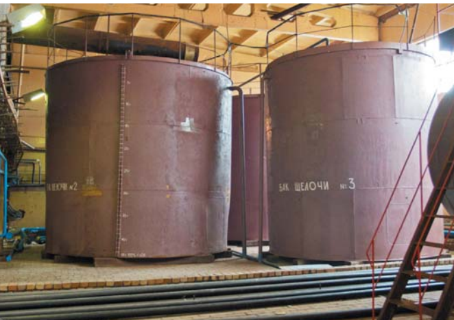
РИС. 1. ▼ Склад Тобольской ТЭЦ
